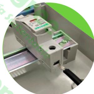
Repita el proceso con el opresor del otro extremo, recordar ajustar a un torque mínimo de 3,5Nm
